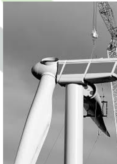
Fallas en Procesos de Mantenimiento
