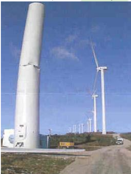
Falla en el proceso de Montaje
