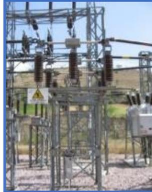
Seccionador de Columnas giratorias. Este seccionador tiene tres apoyos, de los cuales uno es el que realiza el movimiento, manteniendo fijos los otros dos. El dispositivo de accionamiento está ubicado en el aislador central. El campo de accionamiento es en subestaciones a la intemperie de hasta 110 kV
