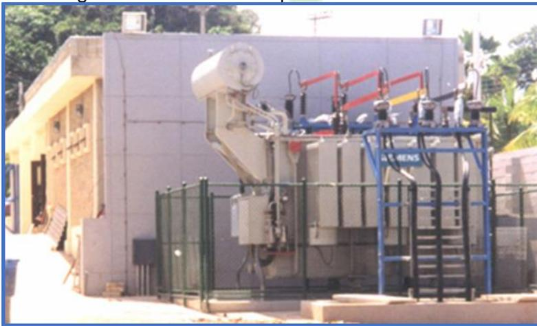
Subestación transformadora de interior. En la imagen se puede apreciar que a pesar de ser una instalación interior, el transformador se sitúa en el exterior
