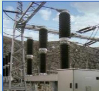
El Interruptor de potencia es un dispositivo electromecánico cuya función es la de conectar y desconectar circuitos eléctricos bajo condiciones normales o de falla.
