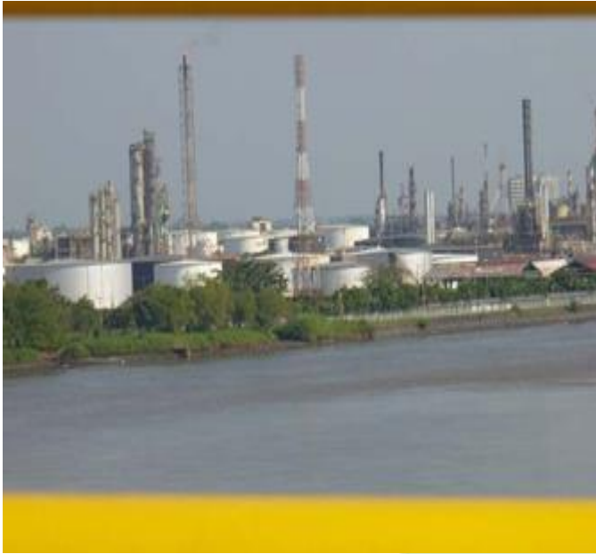
Refinería de Baranca zona de tanques
