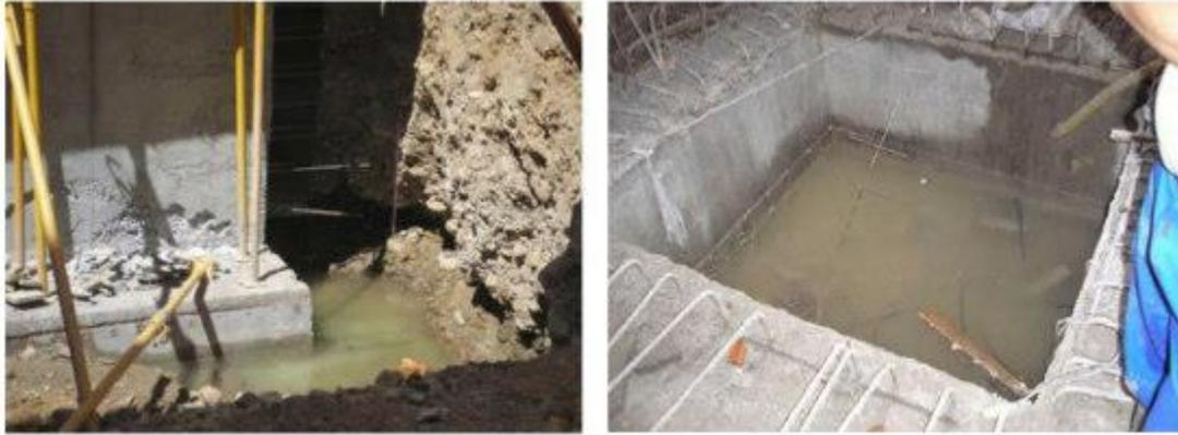
Al construir bajo rasante cualquier elemento, (zapata, muro, pantalla, foso, etc.) se crea un efecto de barrera a los flujos subterráneos que altera los niveles freáticos) o sus trayectorias.
